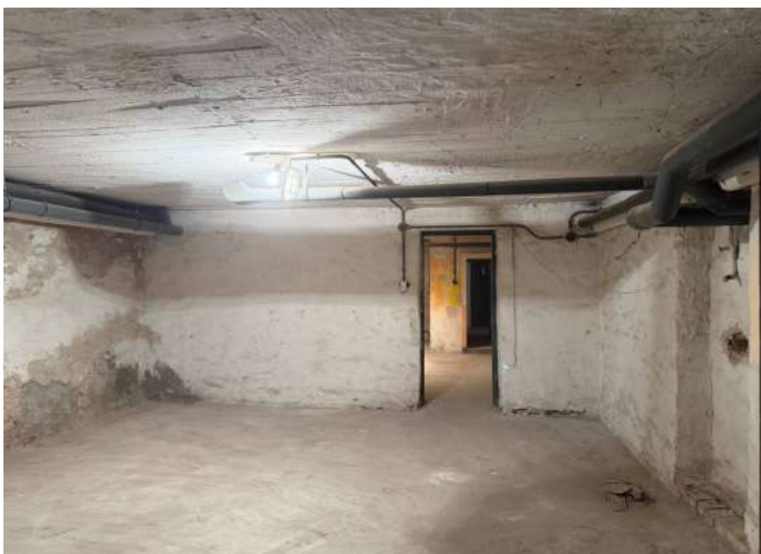
Zdjęcie 6: Piwnica – widoczne zawilgocenia ścian, odspojenie tynków, ubytki w zaprawie murarskiej, lokalne naprawy.
