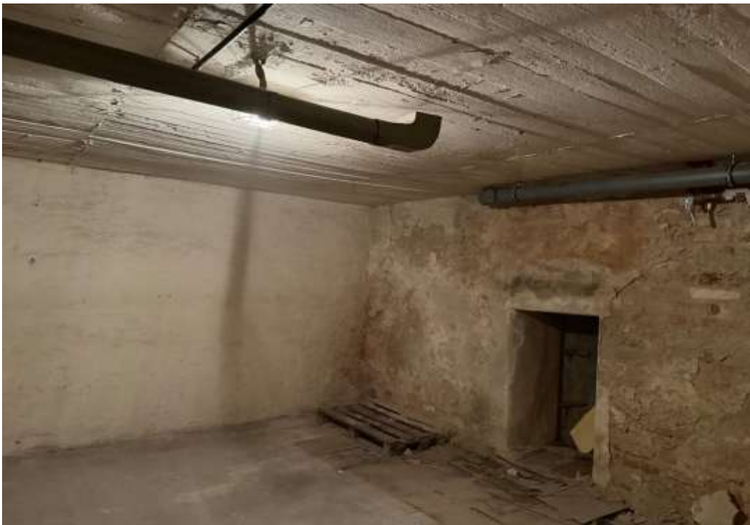
Zdjęcie 4: Piwnica – widoczne zawilgocenia ścian, odspojenie tynków, ubytki w zaprawie murarskiej.
