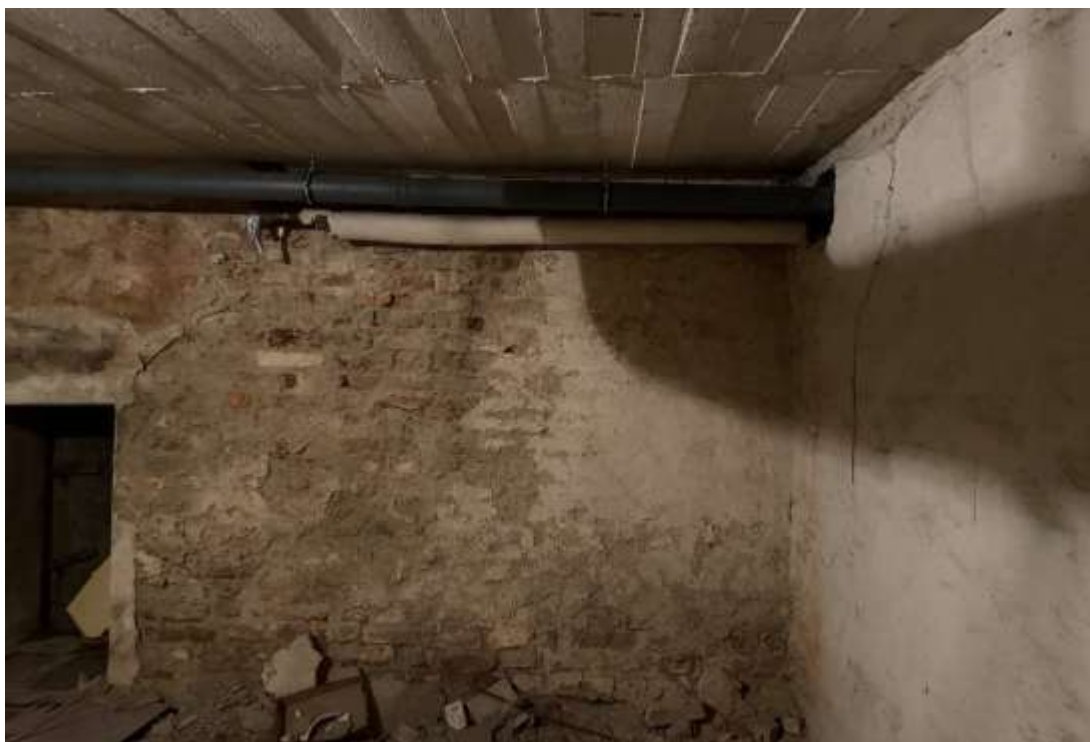
Zdjęcie 5: Piwnica – widoczne zawilgocenia ścian, odspojenie tynków, ubytki w zaprawie murarskiej.
