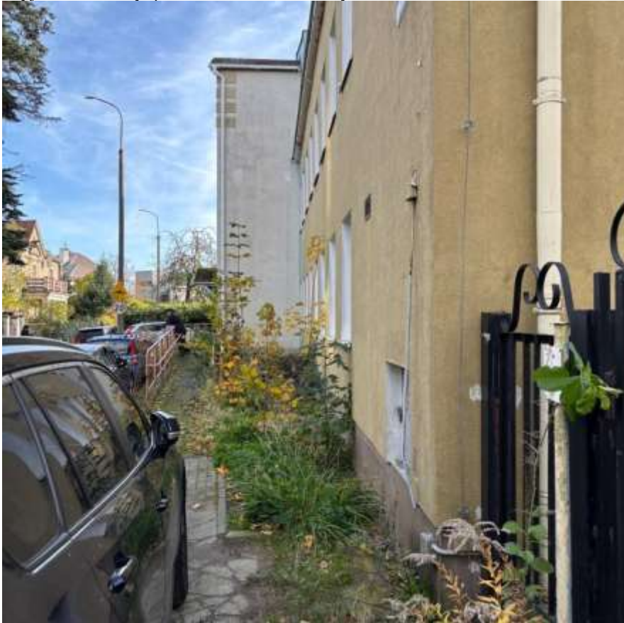
Zdjęcie 3: Ściana frontowa – roślinność przy samym murze, gromadzenie wody przy ścianie fundamentowej, brak opasek drenażowych.
