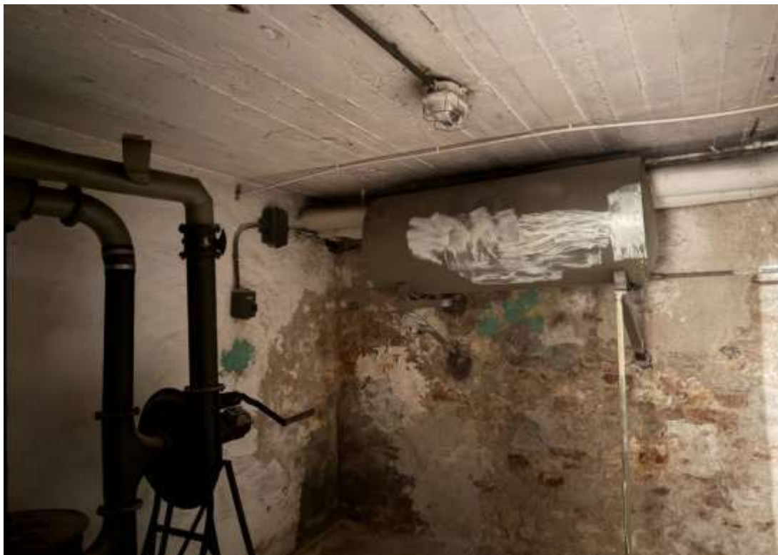
Zdjęcie 7: Piwnica – widoczne zawilgocenia ścian, odspojenie tynków, ubytki w zaprawie murarskiej, lokalne naprawy.
